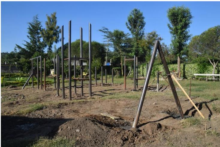
Bohrarbeiten der U-Profile für die Befestigung des Kletternetzes.
