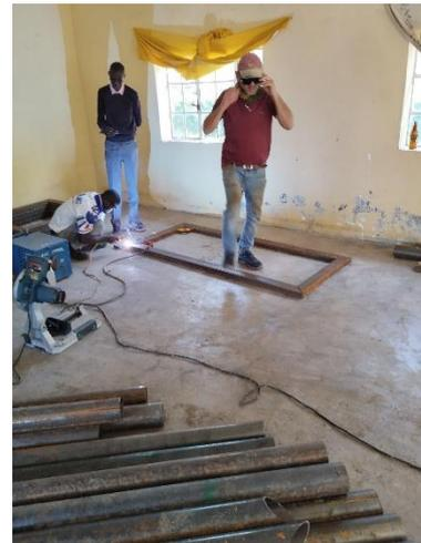
Parallel wurden von Dennis, im Klassenraum, die waagerechten Podeste, zur Fixierung der Rohre, geschweißt.
